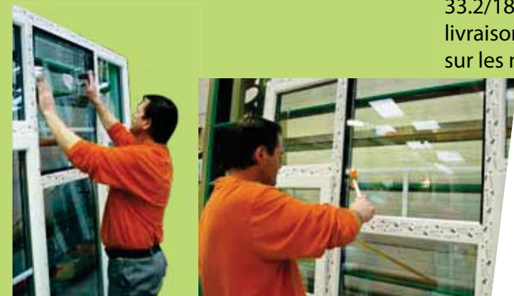
Pose du vitrage et des parclozes
